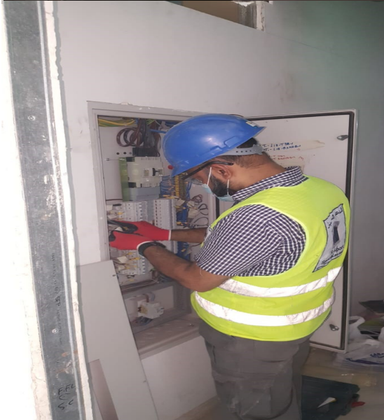
١٨:٣١:٥٨ ٢٠٢٠/٠٧/٢٢ Level 17 - 1st.Fix IP/KNX system R.T. parcel 5.03 electrical work
